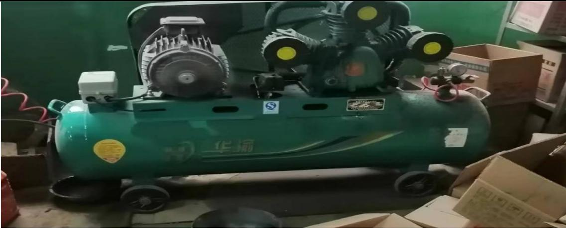
图4.1-7 空压机及减振设施
